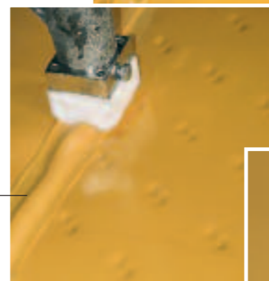
Saldatura a mezzo estrusore
